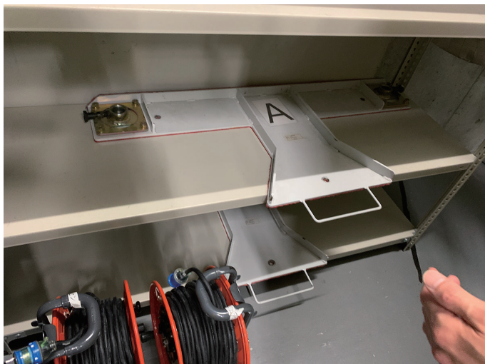
A,B のベースの 3 点をボルトで締めて固定
